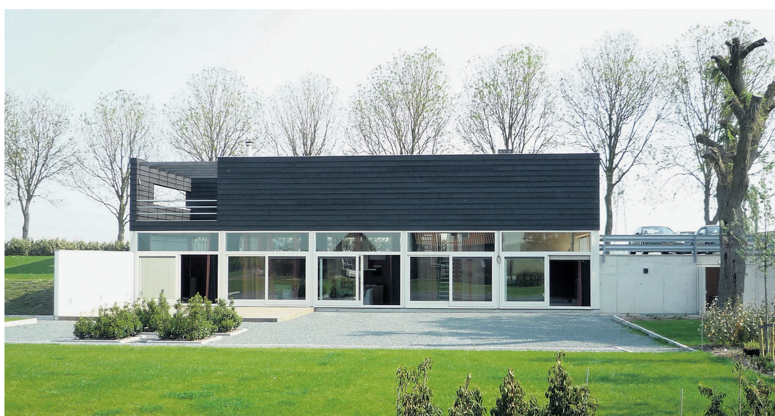
Het dijkhuis gezien vanuit de tuin. Links het terras op de eerste etage.
